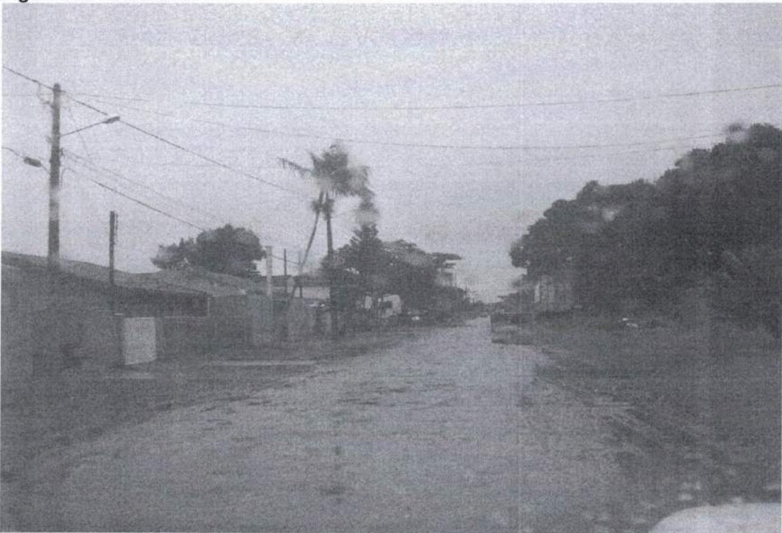
Estruturas da Iluminação nos bairros afastados do centro
